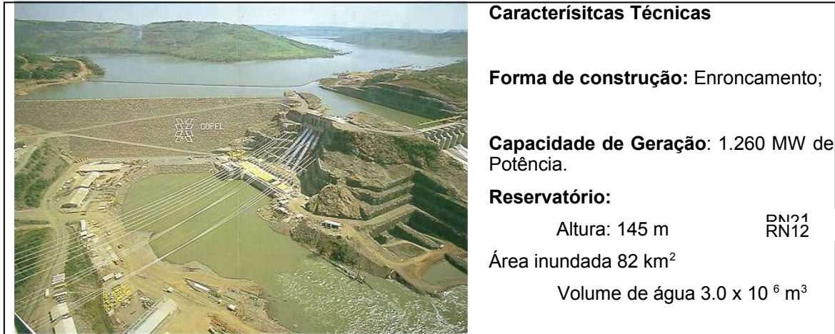
FIGURA 02 – USINA HIDRELÉTRICA DE SEGREDO
