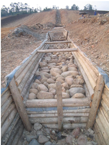
Figura 2: Canal com madeira aparelhada e fundo em seixo rolado.
