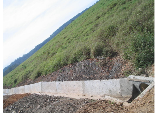
Figura 1: Canal de concreto inserido em área reabilitada
