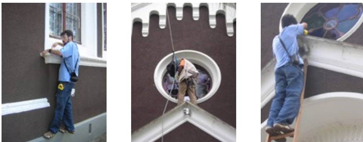
Fig 4a – Foto do levantamento das medidas à trena para o detalhamento de esquadrias. Fig.4b – Arquiteto José Rodrigues Cavalcanti Neto, realizando a prática do rappel sobre a fachada principal, apoiando a corda na escultura para obtenção das medidas do óculo da Igreja. Fig. 4c - Complementação de algumas medidas ainda tiveram que ser obtidas posteriormente Fonte: foto fornecida pelos arquitetos responsáveis pela obra, 2005.
