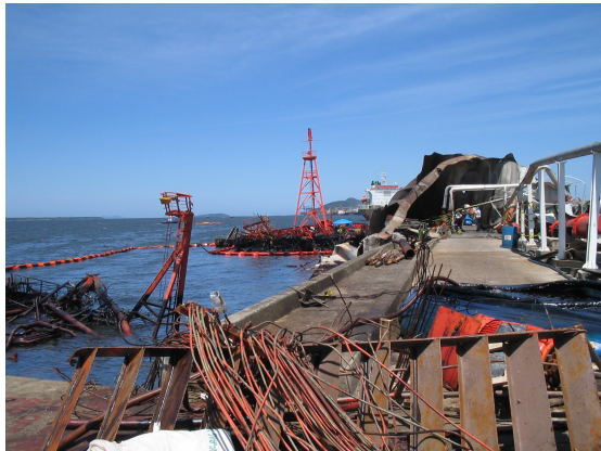
Figura 2 Proa do navio Vicuña submersa ao lado dos destroços no píer.
