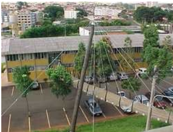
Figura 2: Passarela Estaiada de Madeira construída na Escola de Engenharia de São Carlos – Universidade de São Paulo (EESC-USP)
