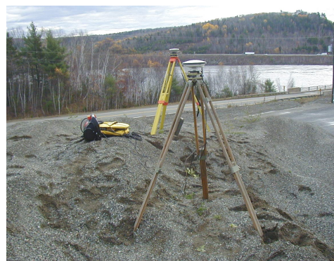
Figura 12: Detalhe dos receptores GPS - REF 2 e REF 3
