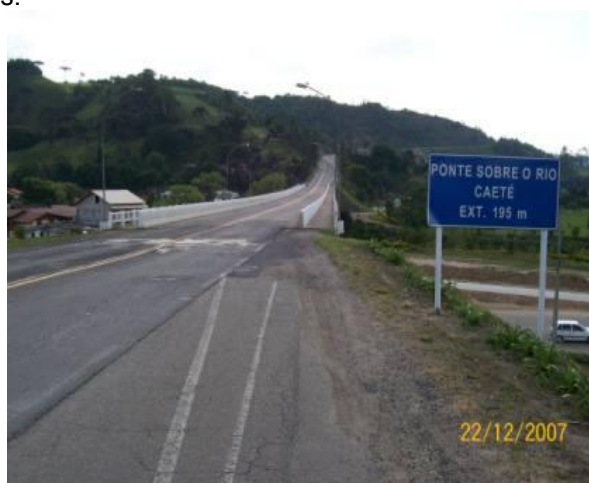
Sinalização na BR-282
