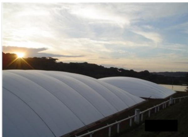
Figura 1 – Biodigestores utilizados para captação do biogás
