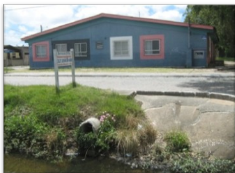
Figura 2: Falta de rede de esgoto no bairro
