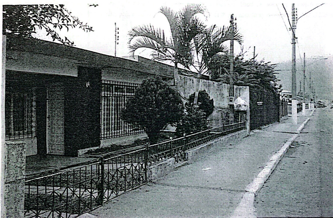
Fotografia nº 4 - Edificações no Bairro Santa Mônica, tendência de construir 2 pavimentos com o máximo da altura permitida (7,20 m), sobrando pouco para elevar a obra acima do nível do logradouro. Rua Joe Colasso.
