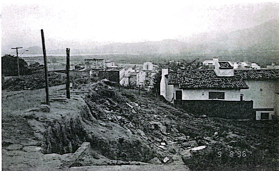
Fotografia nº 1 - Escorregamento provocando destruição de parte da via, cuja implantação ocorreu em área de declividade acentuada - Rua Europa.
