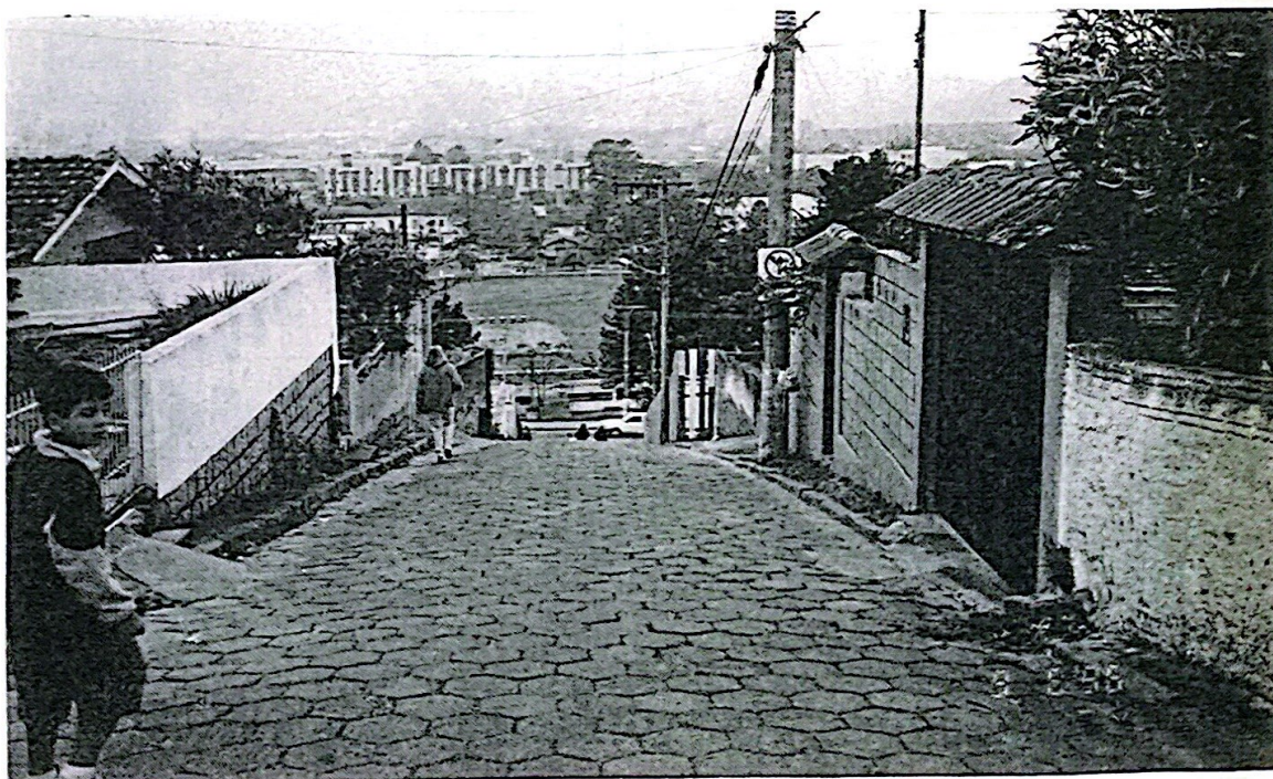
Fotografia nº 2 - Inclinação acentuada de via, onde pode-se observar a necessidade de técnicas construtiva onerosas para contenção dos taludes. Servidão José Ventura.
