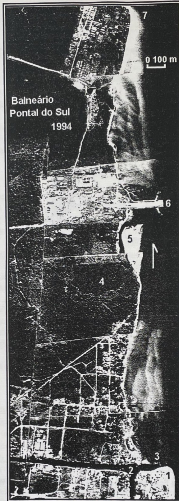
Figura 4: Situação do Balneário Pontal do Sul em 1994: (1) Ponta de Embarque para a Ilha do Mel; (2) rio Perequê desviado para o Canal do DNOS; (3) Dique de contenção para a estabilização da foz do canal; (4) rio Penedo; (5) esporão da foz do rio Penedo; (6) trapiche da TECHINTE; (7) Ponta do Poço. O sentido do transporte de deriva litorânea acha-se indicado pelas setas.
