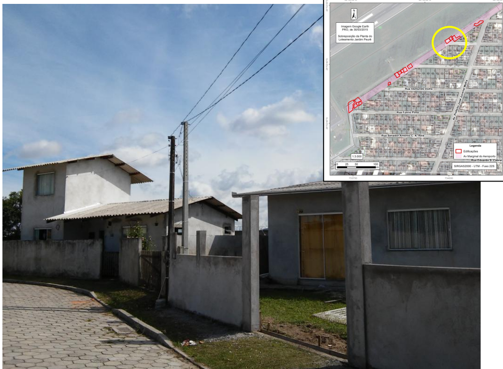
Figura 5 - Edificações recém-construídas sobre o trecho não aberto. Fonte: Autor.
