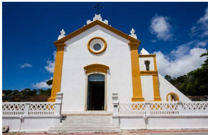
Figura 1. Fachada da Igreja de Nossa Senhora das Necessidades
