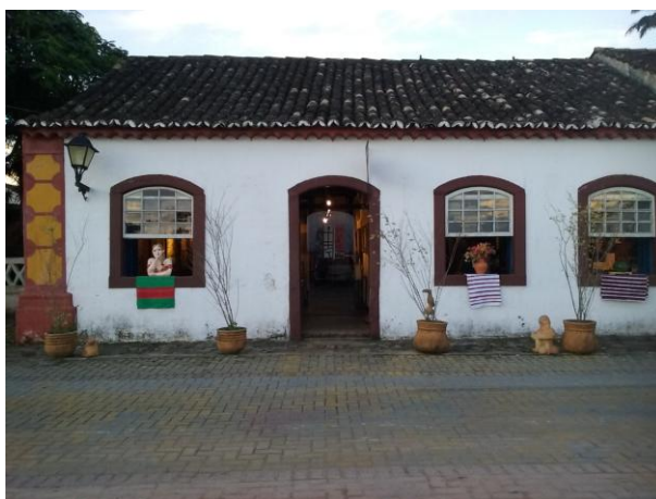
Figura 2. Fachada da Casa Açoriana Artes e Tramóias.
