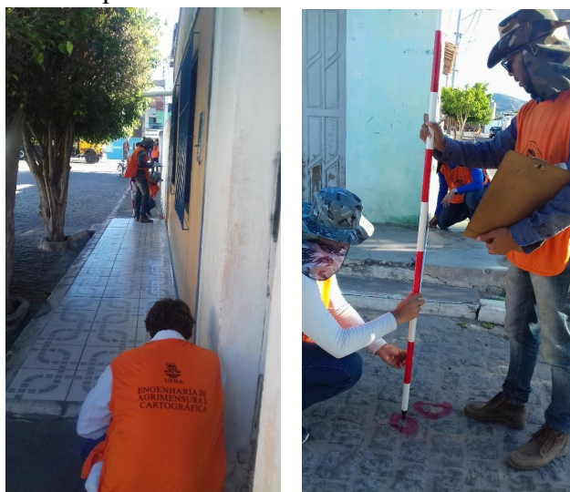
Figura 4 - Método do alinhamento com trena numa quadra em Itatim-BA
