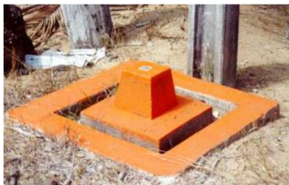
Figura 4 - Marco padrão IBGE Fonte: Padronização de Marcos Geodésicos (IBGE 2008)
