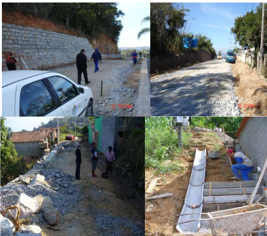
Figura 8 – Obras de estruturação nas comunidades do Maciço do Morro da Cruz – Programa de aceleração do crescimento - PAC – Fonte: Prefeitura de Florianópolis/SC.
