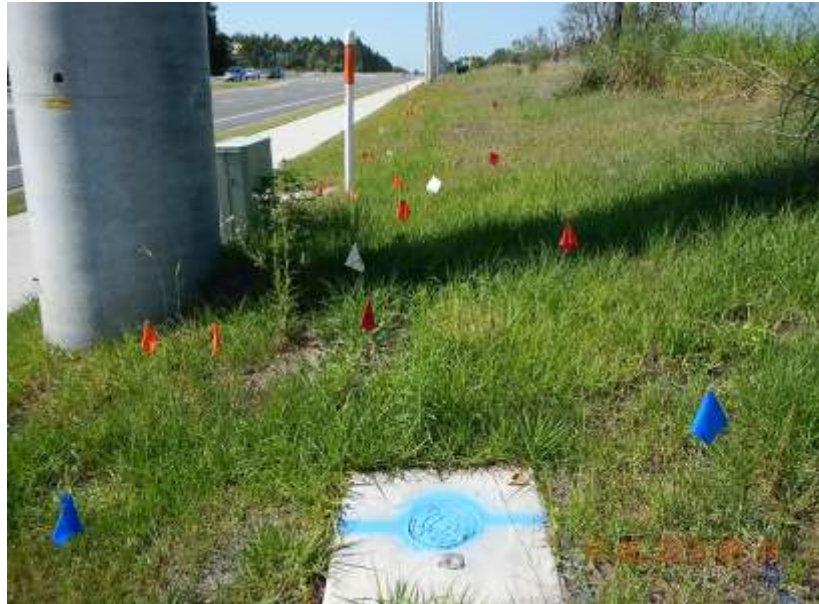
Foto 2 – Demarcação das redes de Infraestrutura por bandeiras - detalhe. Fonte: acervo pessoal (2012).
