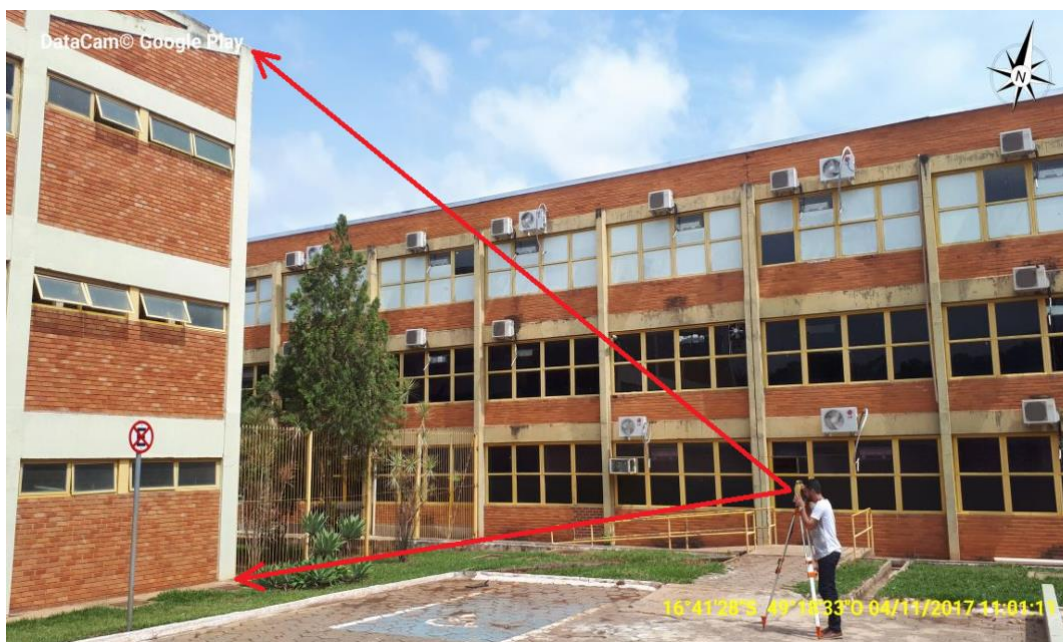
Figura 3. Imagem da locação planimétrica com utilização do teodolito.
