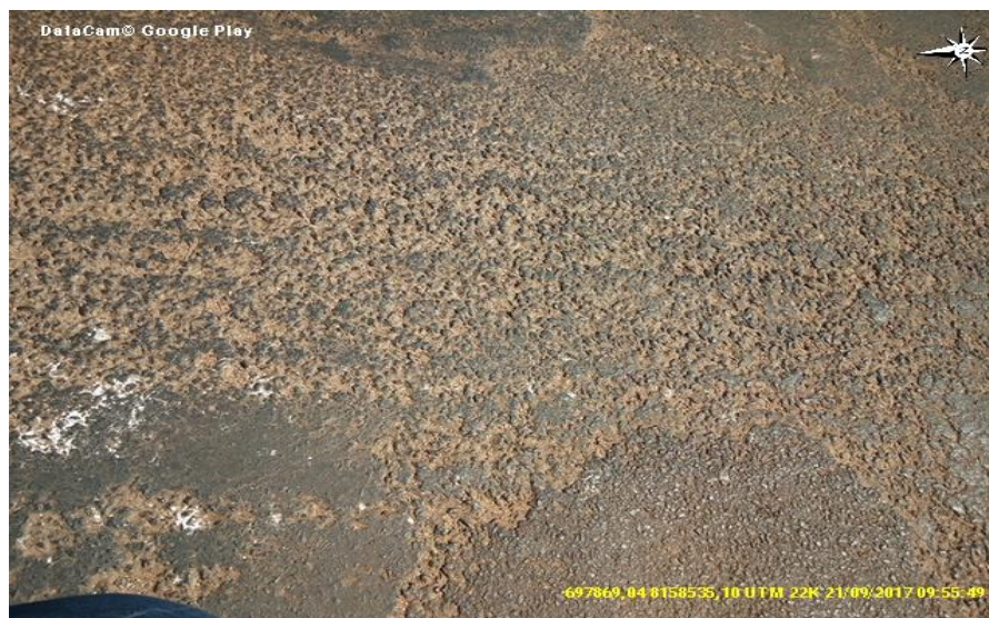
Figura 6: Falha de Bico espargidor Fonte: Google Maps (Setembro/2017).
