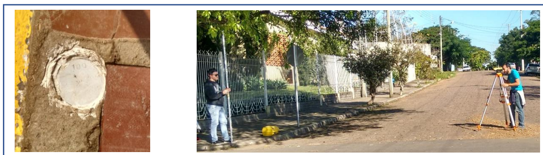
Figura 4 – Chapa de alumínio cravada e numerada e processo de nivelamento.
