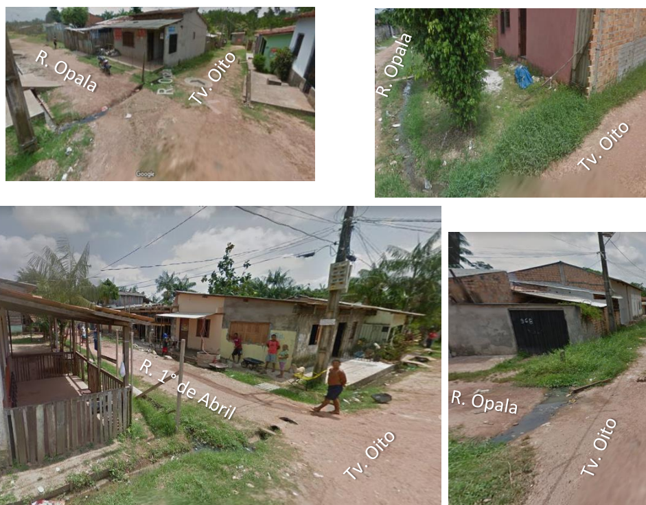
Figura 16 – Imagens da Infraestrutura das vias da área de estudo
