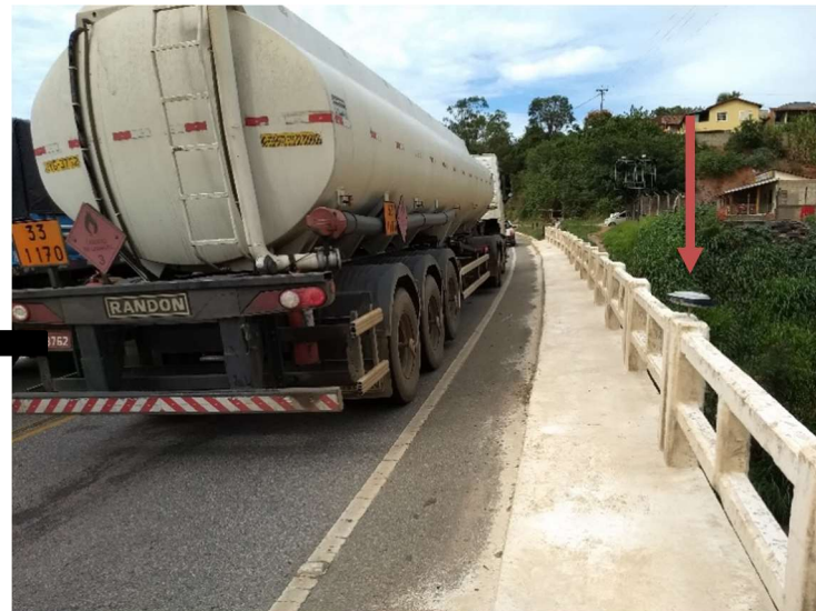
Figura 2: Receptor fixado a ponte
