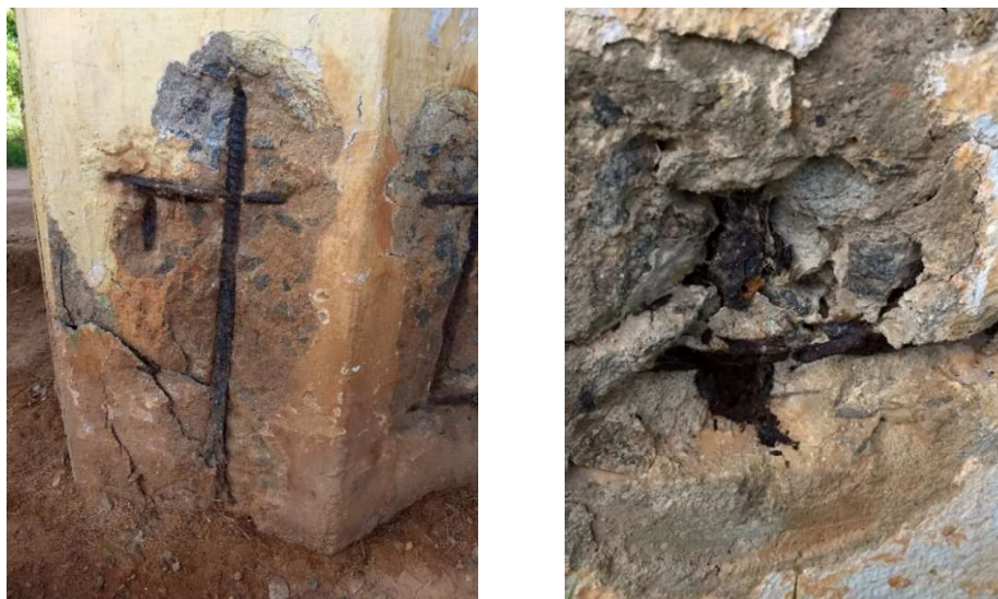
Figura 8: Pilares de sustentação da ponte
