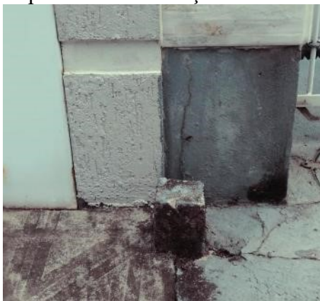
Figura 4: Exemplo de materialização com marco de concreto
