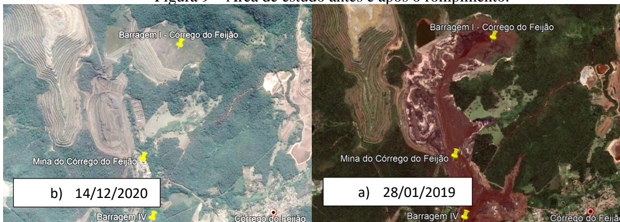
Figura 9 – Área de estudo antes e após o rompimento.
