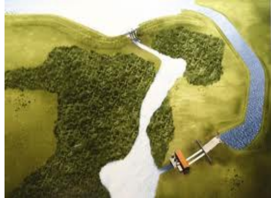
Figura 2 – Fotografia da UHESD.
