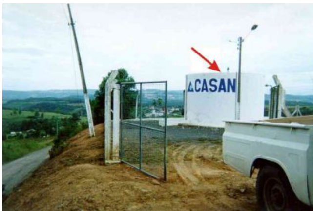
Figura 6 : Estação base em reservatório da CASAN – Santa Cecília
