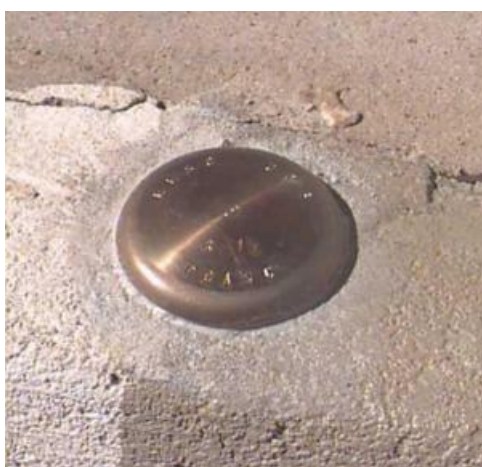
Fig. 6 : Chapa de aço inoxidável fixada no passeio
