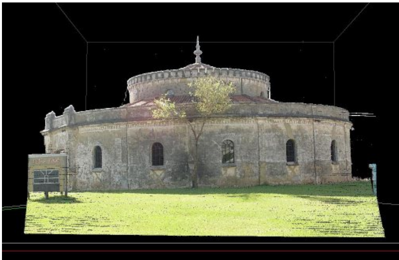
Fig. 7 : Fachada leste do teatro do Paiol
