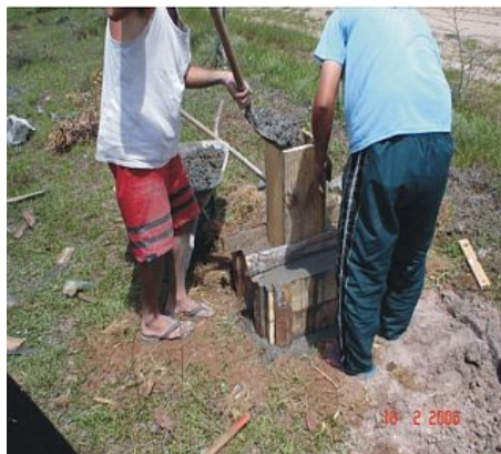
Figura 8 : Marco do Posto, situado na beira da Estrada da Barrosa, nas terras de Danilo Araújo.
