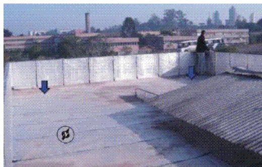
Figura 2- Laje de Cobertura do Auditório
