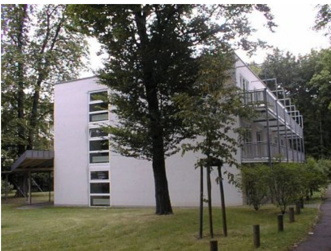
Fig. 5 Prédio identificado nos dados do laser scanner.
