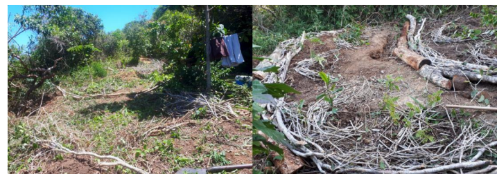
Figura 3 - Transposição de Galharia em Canteiro de Nível
