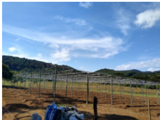
Figura 1 - Construção da estrutura da estufa.
