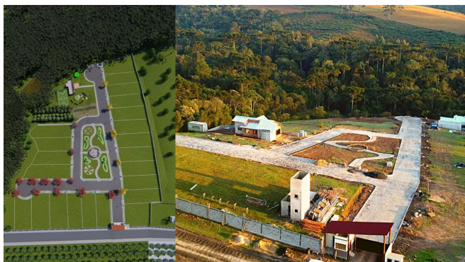
Figura 1 – Projeto e execução do Condomínio Agroecológico Vila das Columbeas, Lages/SC – 2022.
